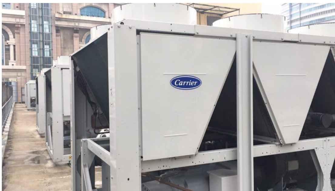
图 1 制热/制冷量为 980kW /920kW 的螺杆式风冷热泵机组
